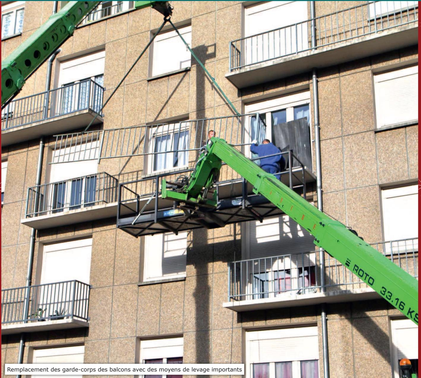
Remplacement des garde-corps des balcons avec des moyens de levage importants
