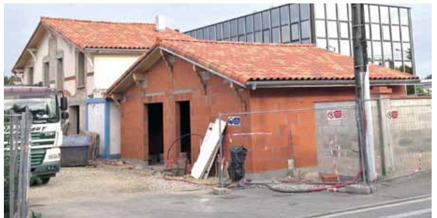
• Les bâtiments sont disposés tout autour d'un espace central qui sera dédié aux parkings.
