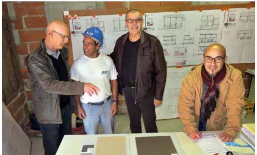
• Bernard Barrier et Michel Soula ( commission travaux de la mutuelle RS ) en discussion sur le choix des carrelages et crépis avec Jean Peixoto chef de chantier et Patrice Ferreira-Canado du cabinet d'architecte Bourdoncle.
